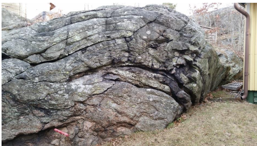
Figur 9-2. Foliationssprickor vid lokalitet 2. Riktningen på sprickorna här är avvikande från resten av området pga veckning.
